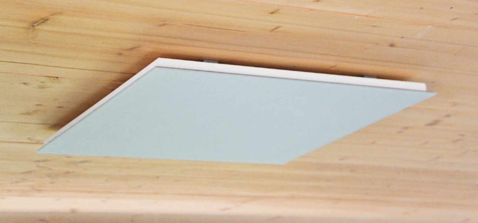
VH-Heizelement an der Decke montiert im Alt- und Neubau.
