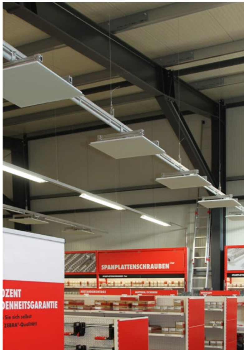
VH-Heizelement in einer Schulaula an der Decke montiert.
