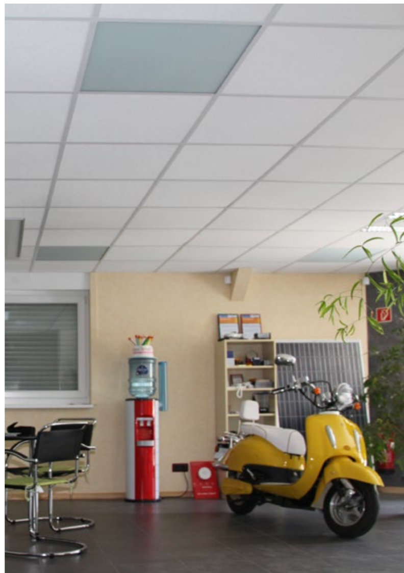
In die Systemdecke eingelegtes Heizelement der Baureihe VH.
