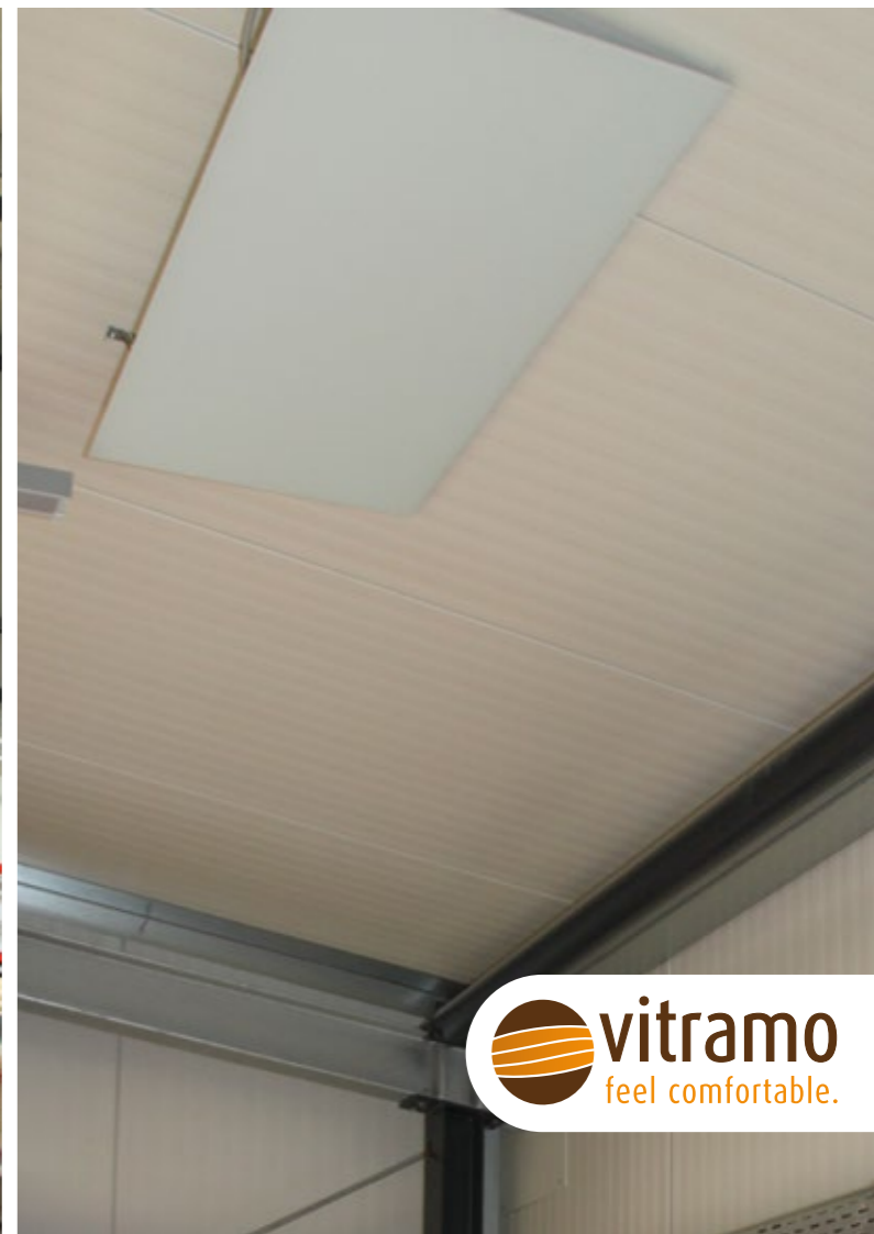
VH-Heizelement in einem Verkaufsraum an einer Traverse abgehängt.
