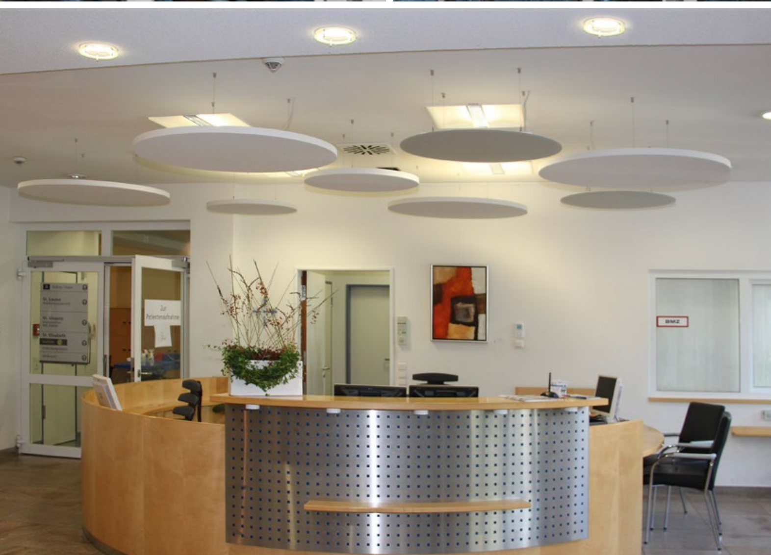
VH-Heizelement in der Aussegnungshalle an der Decke montiert.
