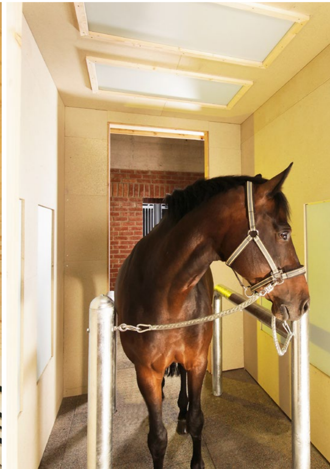
Deckengleich eingebautes VH-Heizelement in der Infrarotwärmekabine für Pferde.
