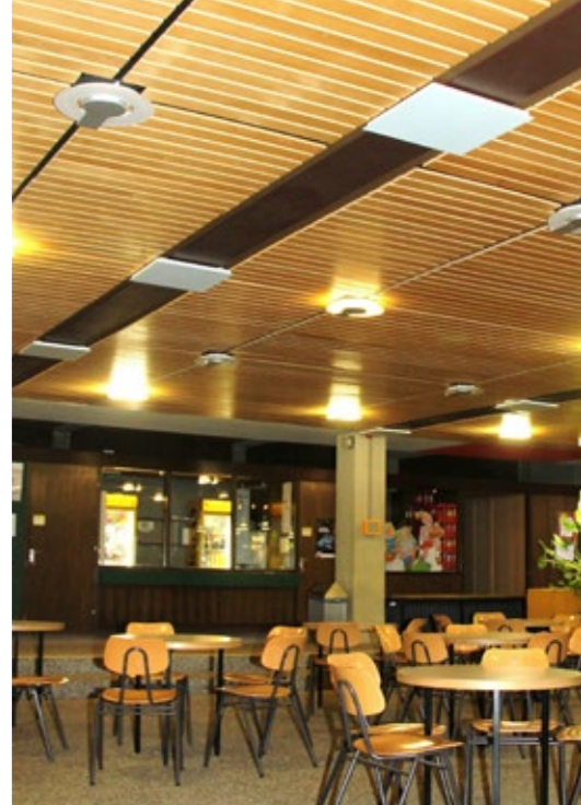
VH-Heizelement in einem Verkaufsraum an einer Traverse abgehängt.
